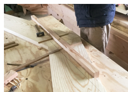
▲の「吸い付き桟」と「しゃち栓」が、二つの破風板を接合し、屋根状とする。▶はそんな屋根や柱を支える「梁」の墨付け風景だ。
