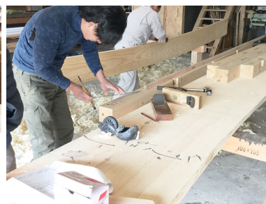
▲の「吸い付き桟」と「しゃち栓」が、二つの破風板を接合し、屋根状とする。▶はそんな屋根や柱を支える「梁」の墨付け風景だ。
